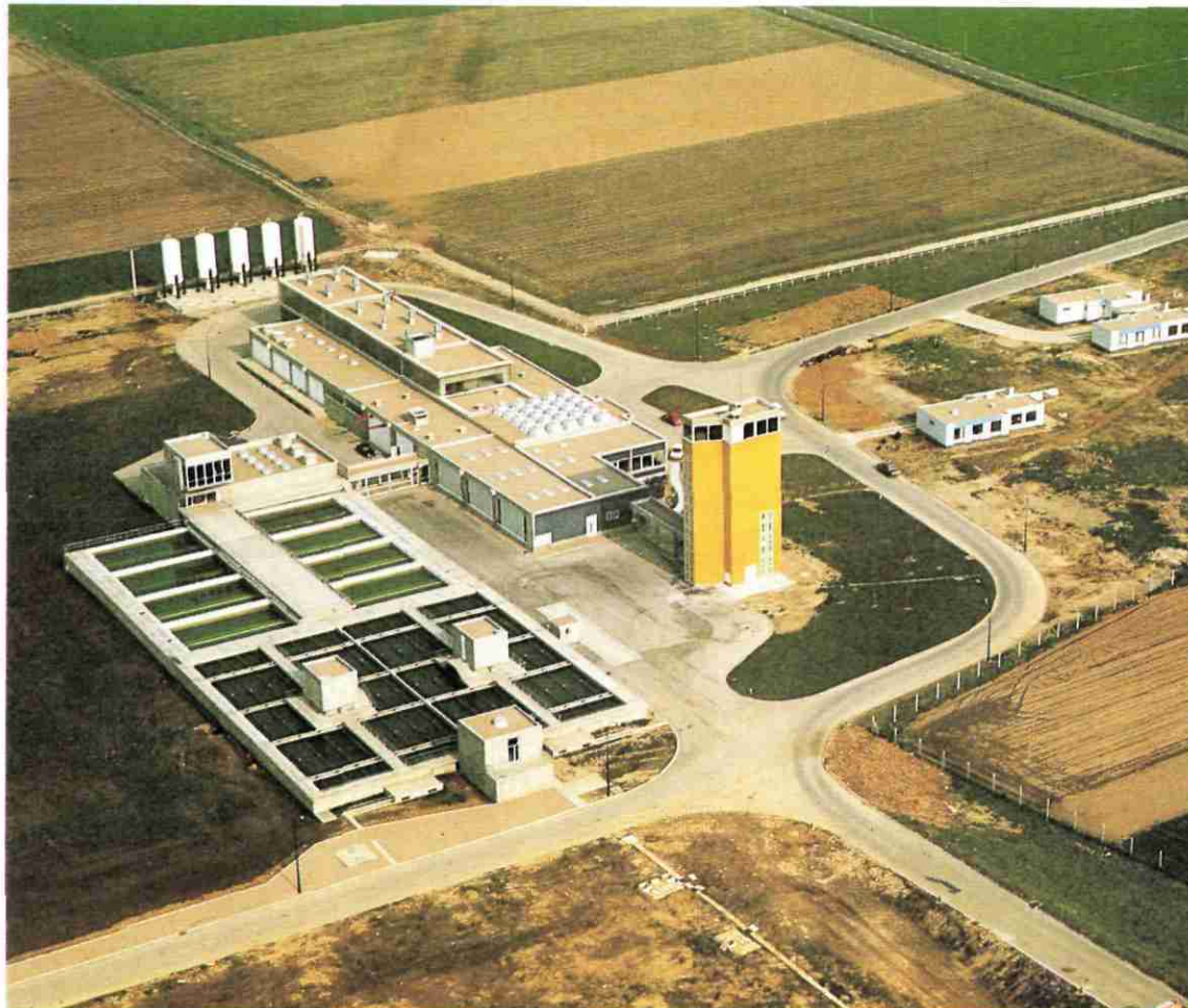
Usine de traitement d'Aire-sur-la-Lys
