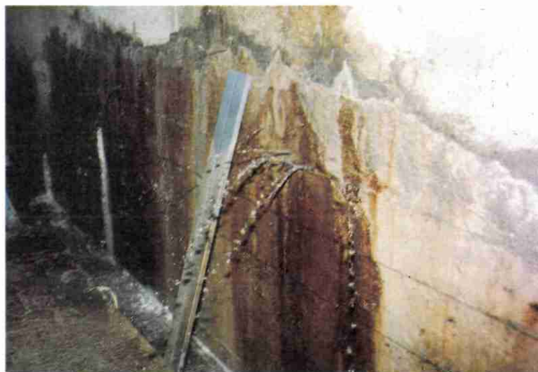
Figure 8 a - Venues d'eau au-dessus de la salle de chauffage d'un immeuble
