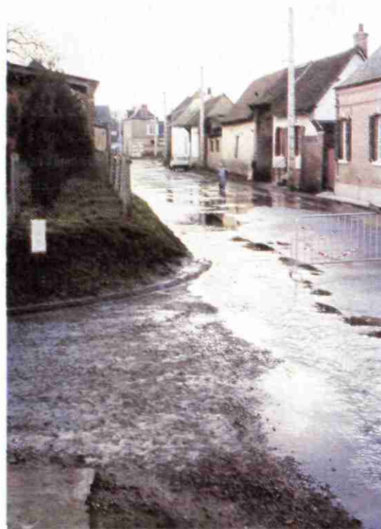
Figure 1 a - Rue principale de Nibas (Somme) canalisant les eaux émergeant des bas côtés
