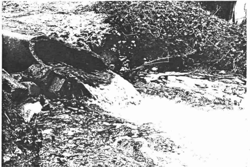
Exutoire étang chateau
