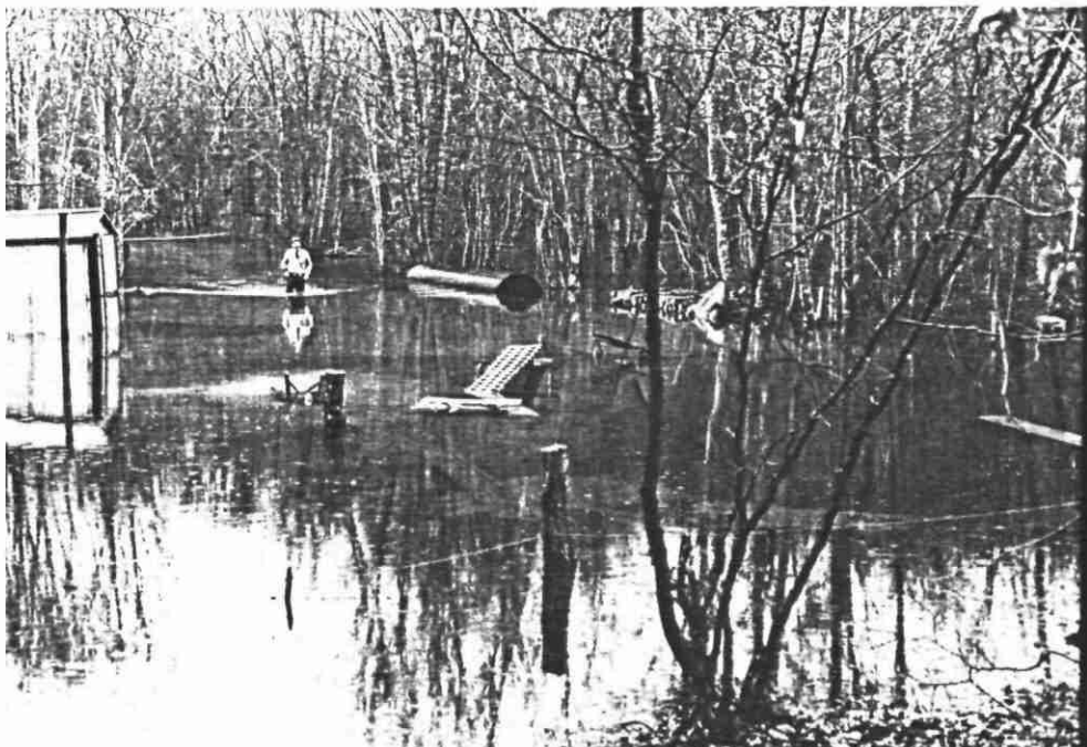
Chantier du captage du puits de l'Abime
