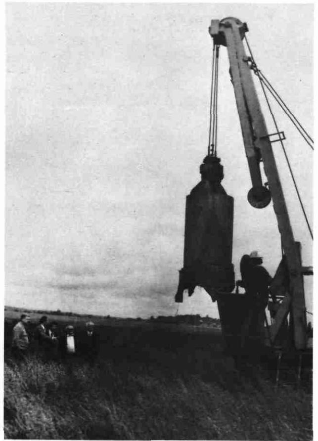
b) Benne trépan en position de battage
