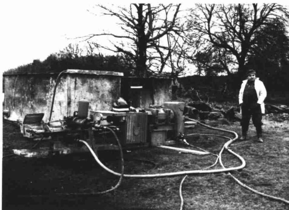
Photo 2 - Les réservoirs d'eau et la pompe d'injection
