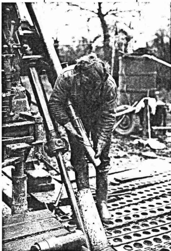
Récupération de la carotte à la sortie du carottier
