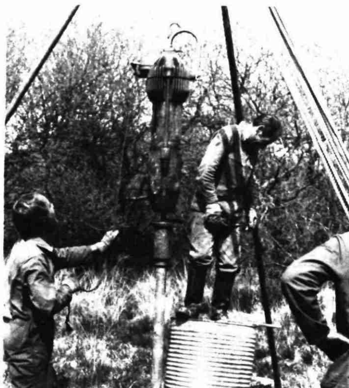
Photo 7 : Enfouissement des tubes par battage à l'aide du mouton Delmag
