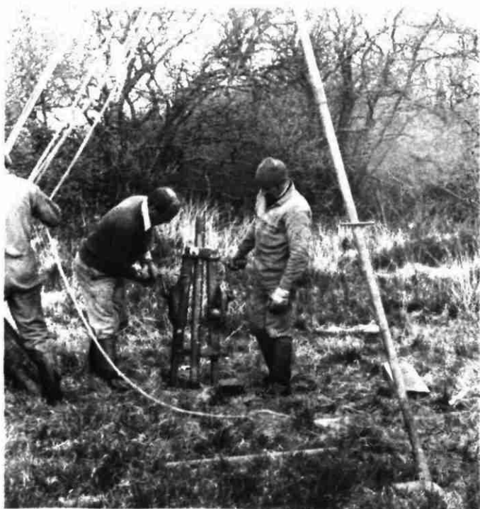
Photo 8 : Remontée manuelle des tubes à l'aide des crics
