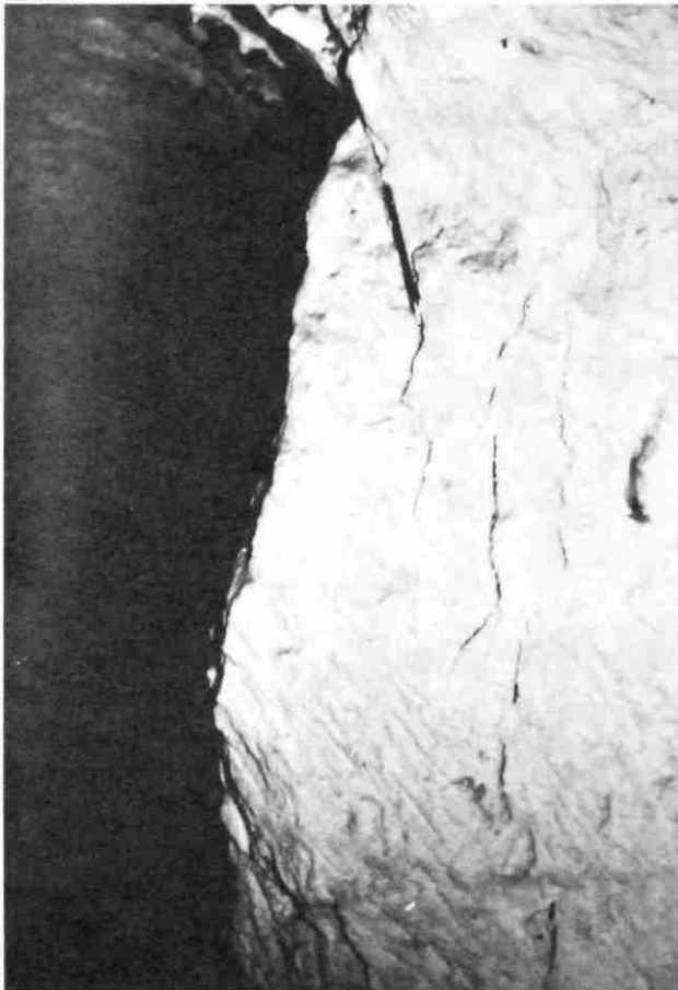
Détail de la fracturation d'un pilier (carrière de Beauregard, Rochecorbon, Indre et Loire)
