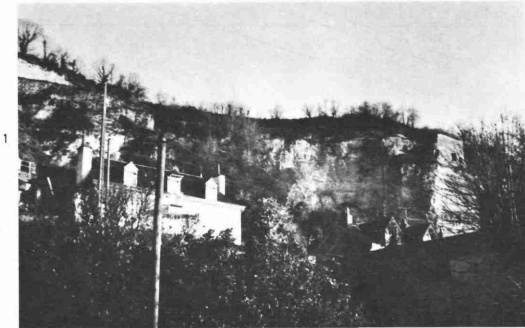
Partie ouest de l'écroulement
