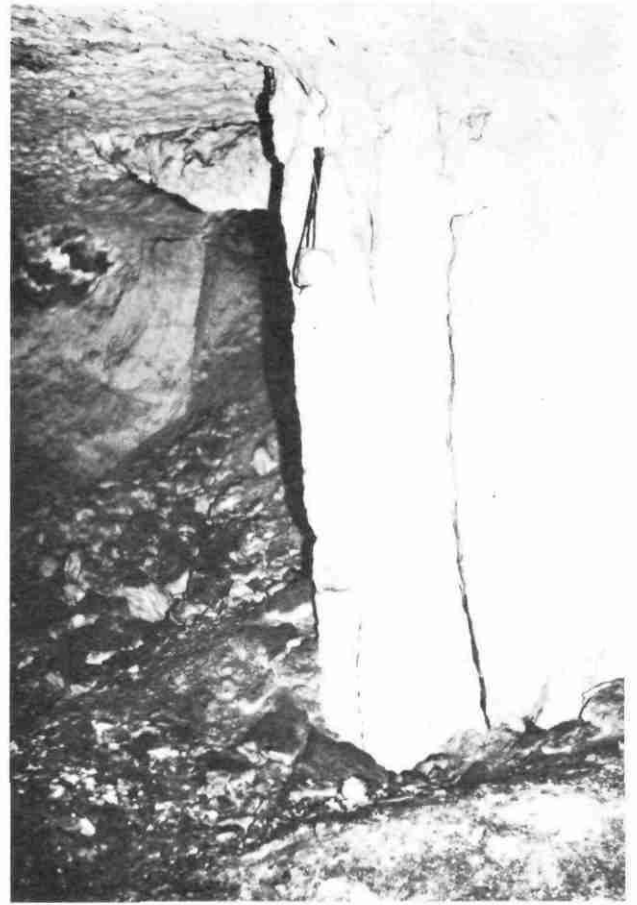
Piliers fracturés (Rochecorbon, carrière de St Georges)
