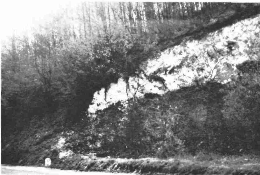
Bancs calcaires du Turonien inférieur affaissés par suite d'un sous cavage naturel
