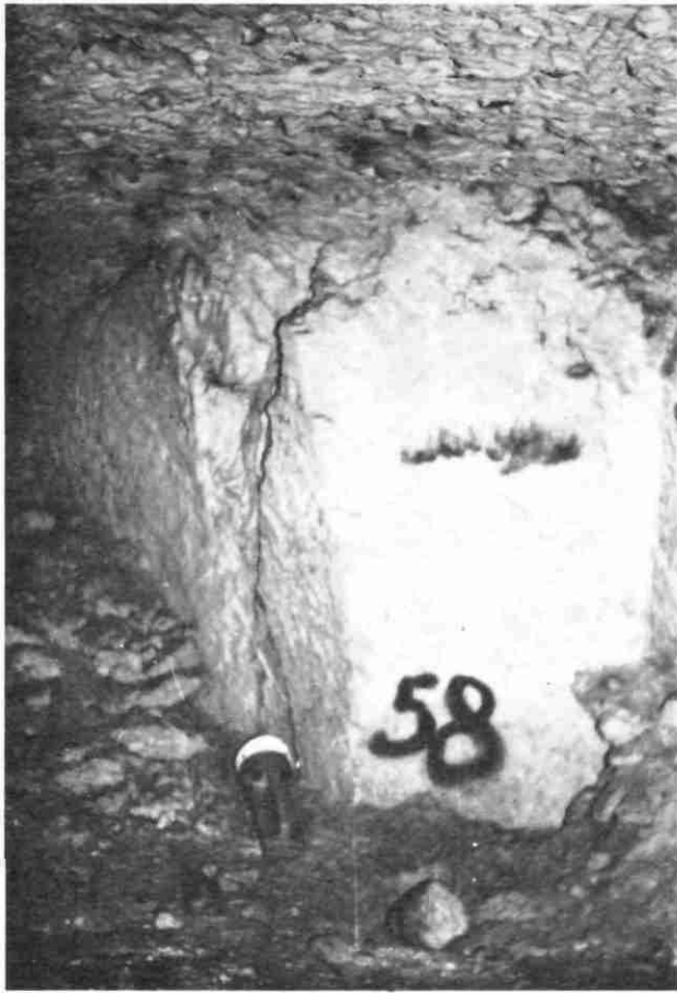
Piliers fracturés (Rochecorbon, carrière de St Georges)
