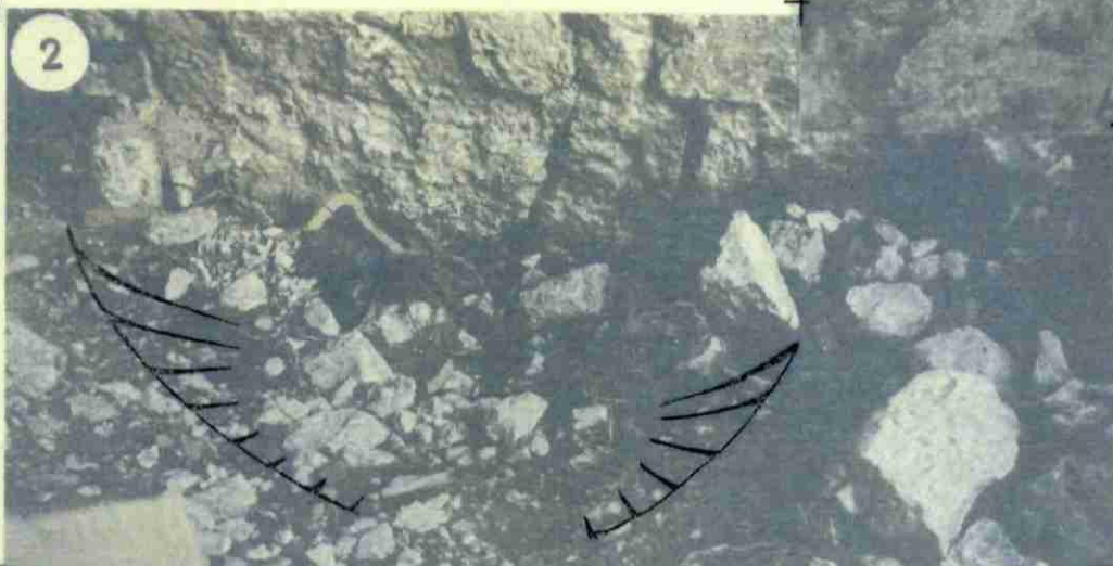
1 2 - Zone "B". Vue de l'intérieur de la galerie. Entonnoir creusé l'eau de ruissellement de la plate forme, cause des désordres L'eau s'engouffre par cet orifice, sous le mur du chateau pour miner ensuite à l'intérieur de la grande fissure sous-jacente 3 - Coulée de boue (à l'intérieur du pointillé) visible sur 4 m s le bloc n°3, laissée après le débouillage de la fissure qui pa sous le mur du chateau. 4 - Décollement de la partie du mur d'enceinte du chateau au niveau de la sole de la galerie.
