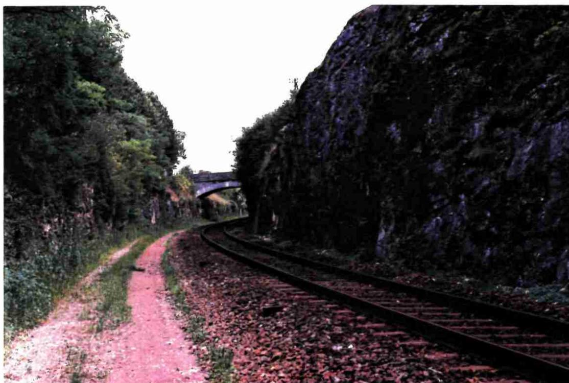
Photo 4 - Calcaire du Turonien supérieur dans la tranchée de la voie ferrée. La roche est massive, peu fracturée et il y a peu de karstification.
