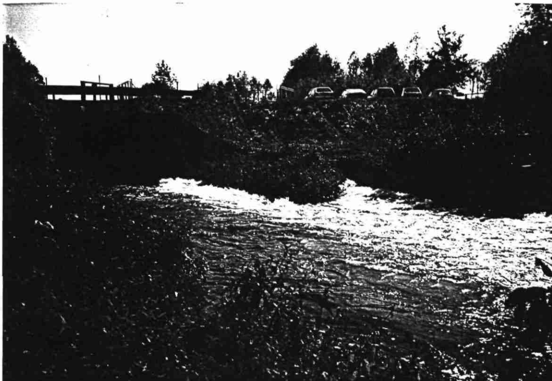
Prises d'alimentation du Rhin Tortu , à partir du bassin de compensation de Plobsheim : vue de l'aval .
