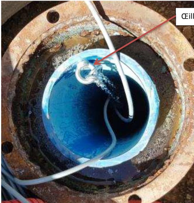
œillet de fixation avec pince d'ancrage et chainette
