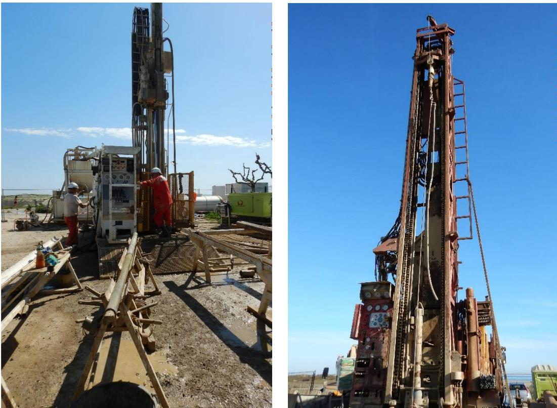
*Illustration 5 : Vues du chantier de forage (carotté à gauche et rotary à droite).*
