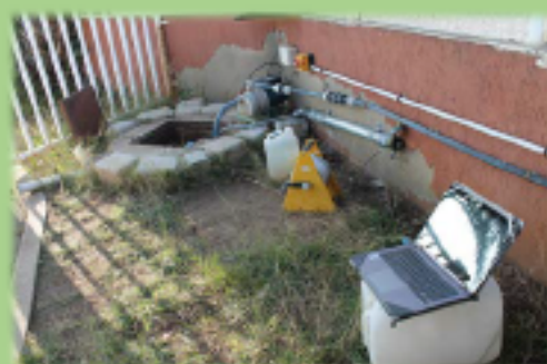
Équipement au forage S12 (école de Balaruc)
