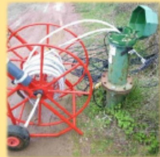
Pompage au forage P4 La Balme
