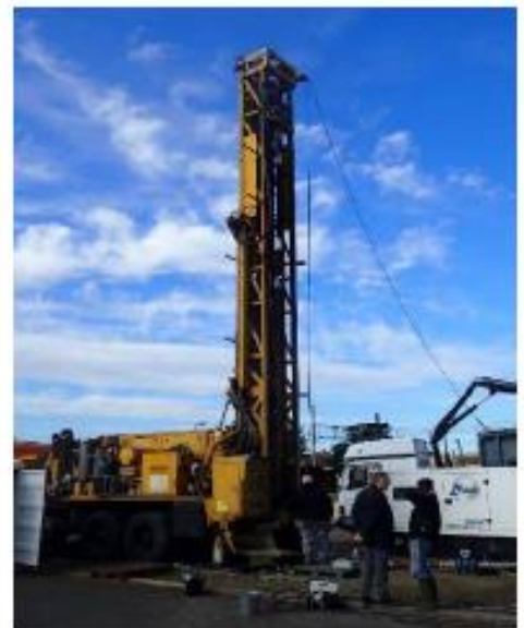
Réalisation du forage d'observation (Janvier 2018)
