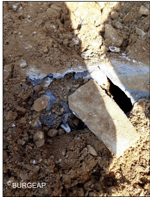
Canalisation en amiante-ciment.
