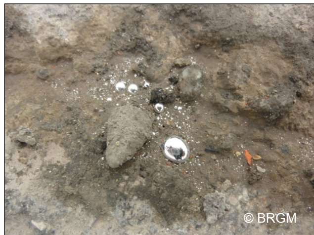
Gouttelettes de mercure libre sur une dalle de béton.
