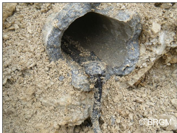
Hydrocarbures pâteux présents dans une canalisation.
