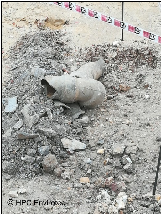
Débris d'une canalisation en amiante-ciment.
