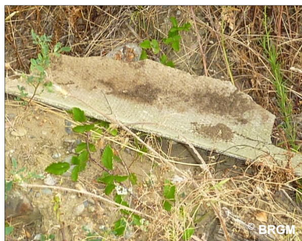
Toiture en fibrociment.
