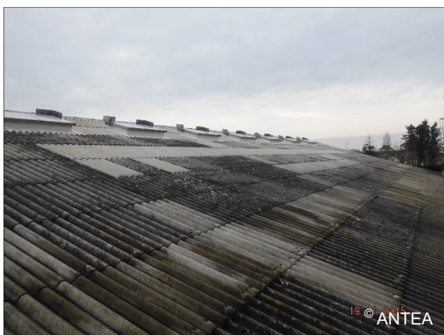
Toiture en fibrociment.
