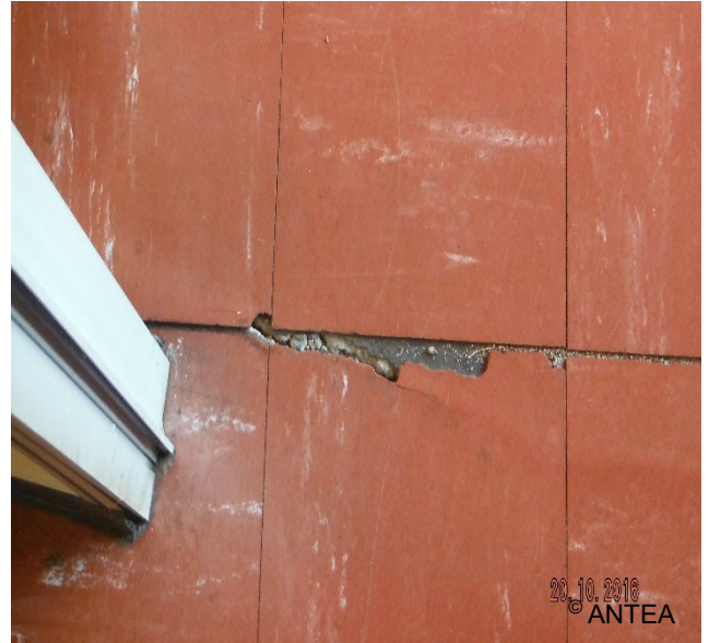
Dalle et colle amiantée.
