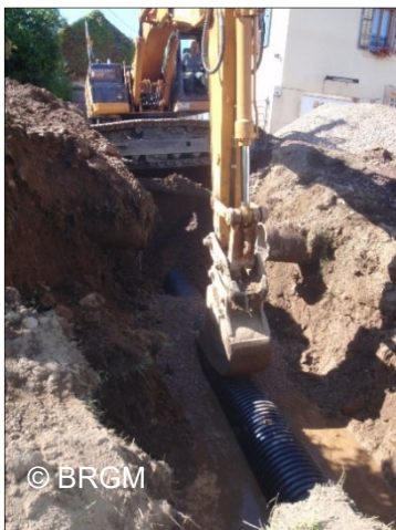
Figure 2 : Exemples de travaux (chantier linéaire avec présence d'une canalisation, et chantier de terrassement)
