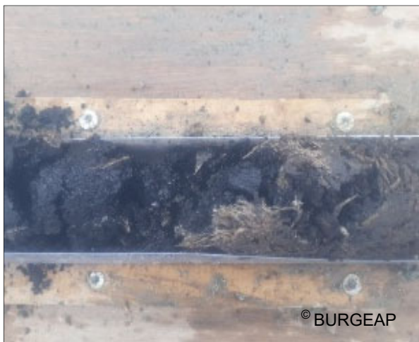
Fibres d'amiante découvertes dans un sondage.
