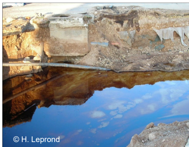
Eaux souterraines impactées.
