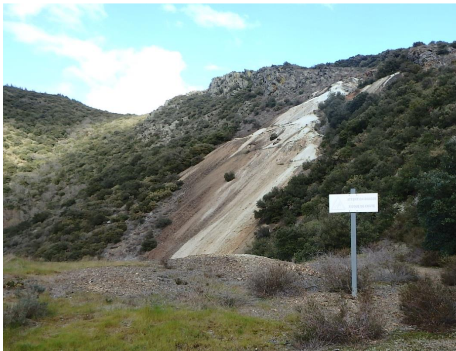
Illustration 42 - Vue générale de la partie supérieure de la verse après crue (21/03/2019).
