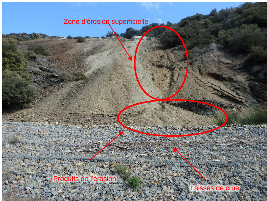
Illustration 48 - Vue détaillée de la partie inférieure de la verse après crue (21/03/2019).
