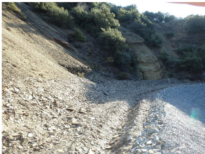
Illustration 50 - Fossé entre le pied de versé et la digue - avant crue (19/11/2015).
