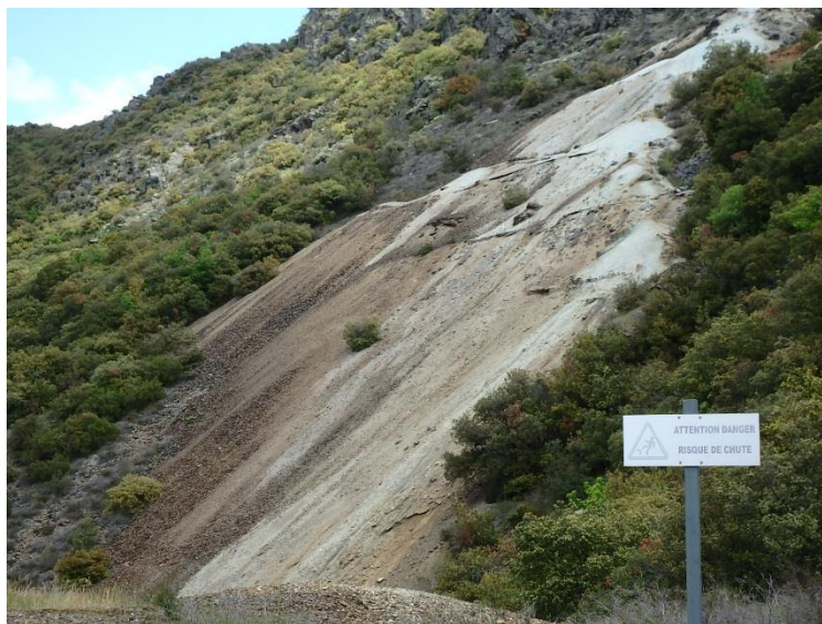
Illustration 41 - Vue générale de la partie supérieure de la verse avant crue (23/05/2018).
