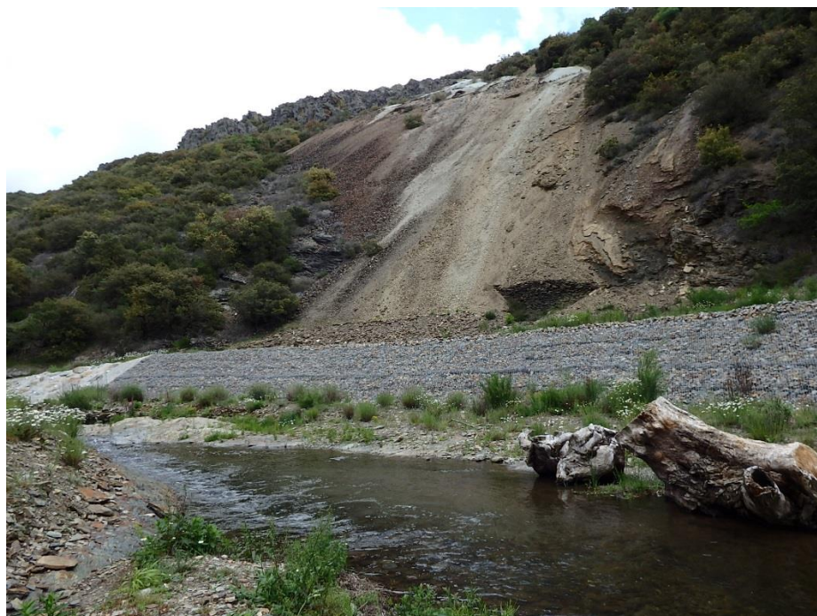
Illustration 43 - Vue générale de la partie inférieure de la verse et de sa protection de pied avant crue (23/05/2018).
