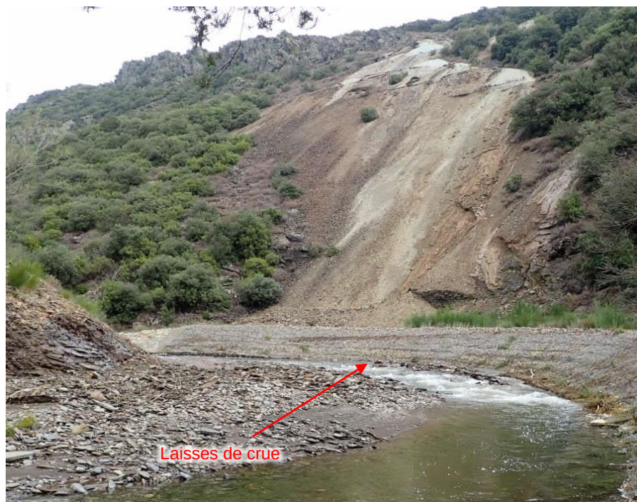
Illustration 44 - Vue générale de la partie inférieure de la verse et de sa protection de pied après crue (17/10/2018).
