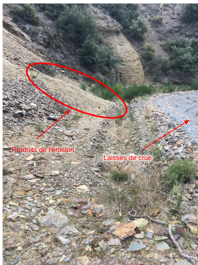
Illustration 51 - Fossé entre le pied de versé et la digue - après crue (20/03/2019).
