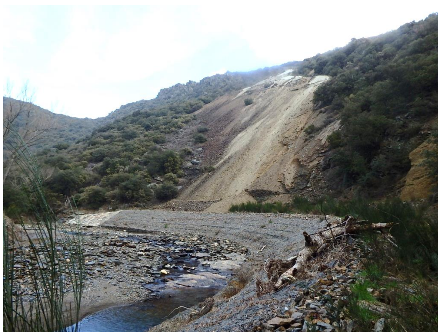
Illustration 45 - Vue générale de la verse et de sa protection de pied après crue (21/03/2019).
