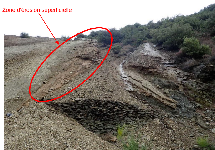
Illustration 47 - Vue détaillée de la partie inférieure de la verse après crue (17/10/2018).
