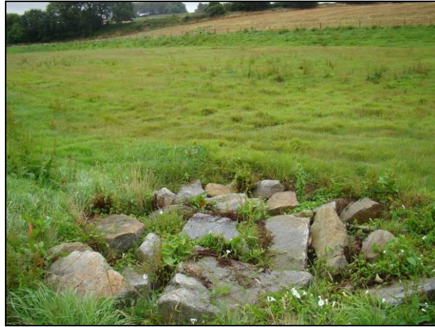
Illustration 41 : Exemple d'un aménagement d'une bétoire par mise en place d'enrochements
