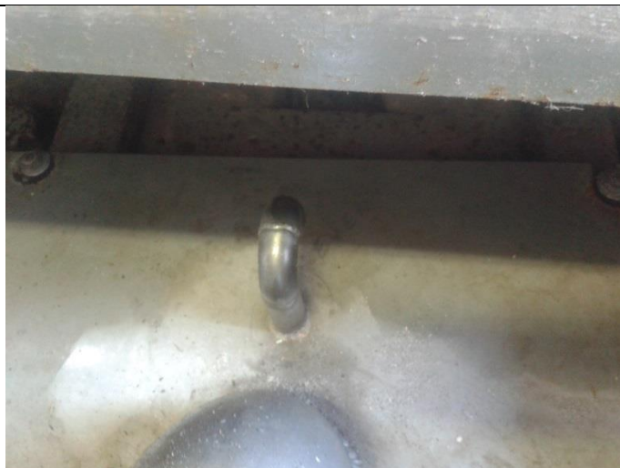
Figure 2 : photo du coude d'accès à l'ouvrage 01673X0009/F (Schorbach – 57)
