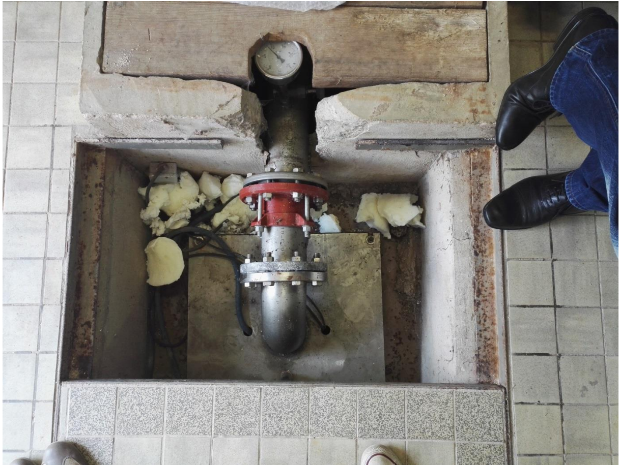
Figure 1 : photo de l'ouvrage 01673X0009/F (Schorbach – 57)
