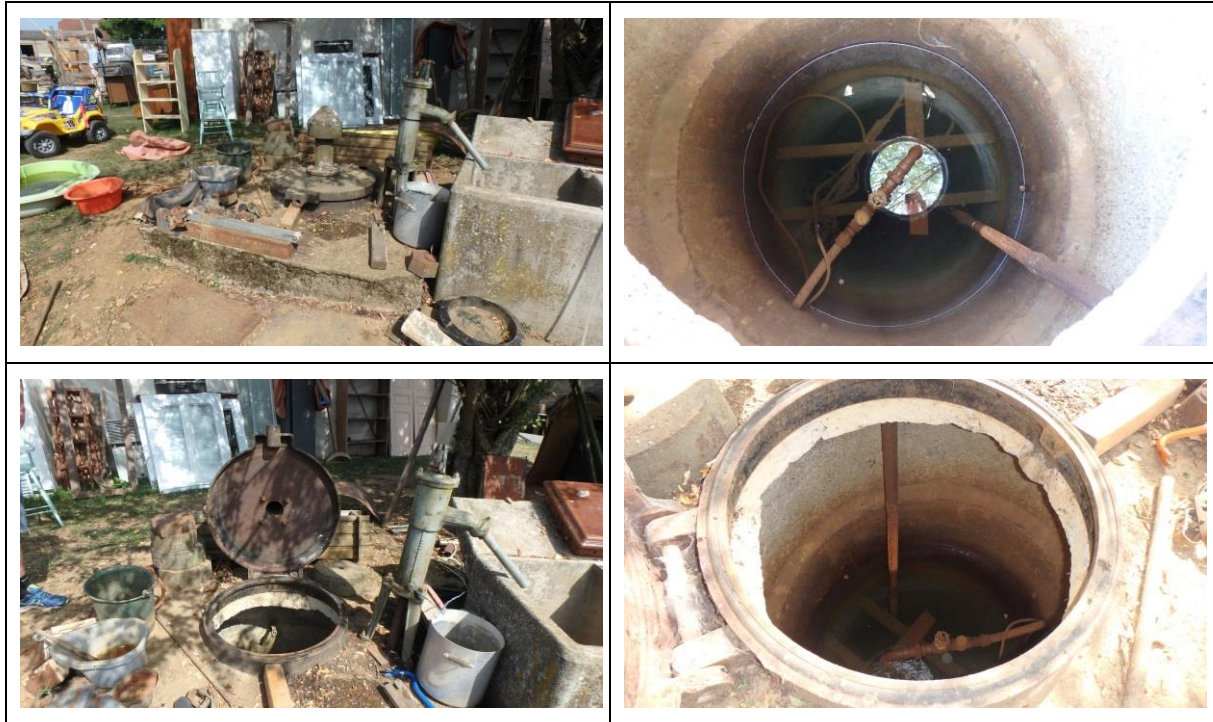
Illustration 19 : Photographies de l'ouvrage « 03733X0002/PU » (DAMMARTIN-SUR-MEUSE, 52)
