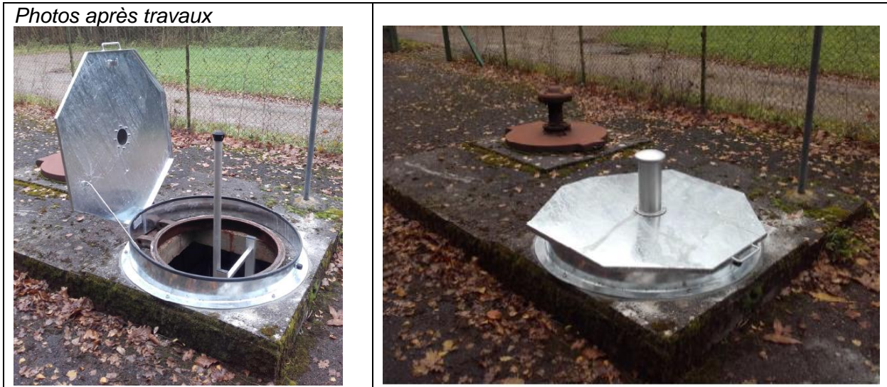
Illustration 17 : Photographies de l'aménagement de la tête de l'ouvrage 02327X0032/F (Voyer - 57)
