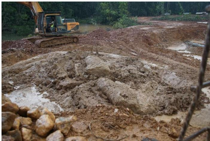
Figure 14 : Cas d'un minerais hétérogène (stérile et gravier aurifères mélangés), chantier de reprise d'anciens travaux (J.L. Nagel).
