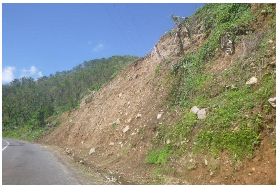
Illustration 10 : Glissements de terrain survenus sur le talus routier amont de la RN1 entre Trois-Rivières et le centre-ville de Gourbeyre
