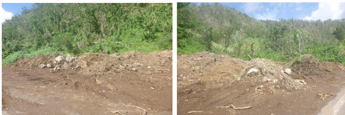
Illustration 9 : Matériaux éboulés entreposés en bordure de la RN1
