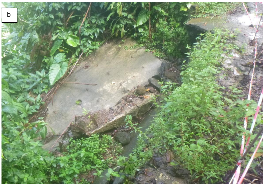
Illustration 8 : Glissement de terrain MVT n°1 dont la niche d'arrachement à l'aval de la chaussée (a) a entraîné la rupture du mur de soutènement (b).
