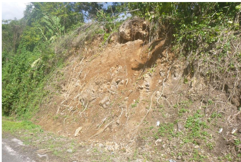
Illustration 11 : Glissement de terrain ayant entraîné des chutes de parties rocheuses survenues le long du talus routier nord de la RN1
