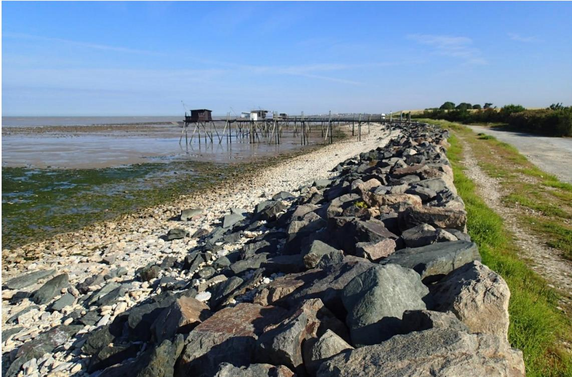
*Illustration 22 - Exemple d'ouvrage longitudinal : digue en enrochement en baie d'Yves (17)
