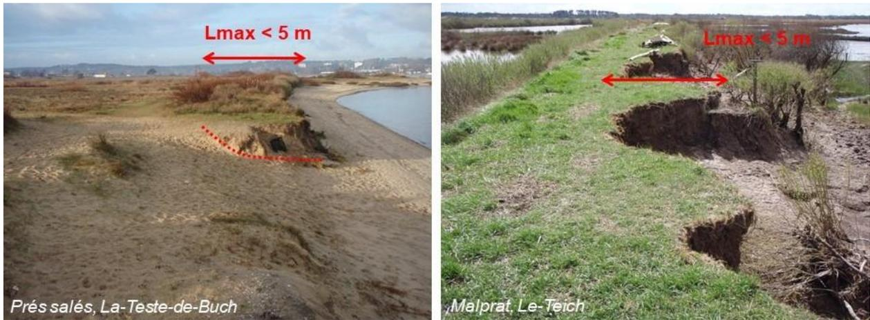
Illustration 35 - Exemple d'érosion marine pour la détermination des  $L_{max}$  sur le pourtour du Bassin d'Arcachon
