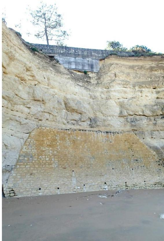
Illustration 24 - Exemple de parade active sur une falaise rocheuse : soutènement maçonné à la pointe de Suzac (17) (photographie ©BRGM, 2017)
