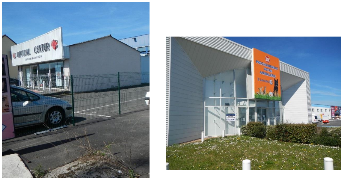
Figure 10 - Exemples de bâtiments dont la vulnérabilité aux séismes a été estimée lors de la visite de terrain dans la ZAC de Plan de Campagne (baie vitrée en façade sur l'exemple de gauche ou enseignes suspendue sur celui de gauche et de droite).
