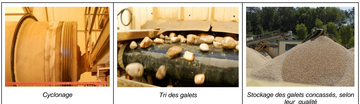
Figure 15 - Étapes de traitement et stockage des produits concassés à l'usine de Thédillac (clichés I. Bouroullec BRGM - 2014).
