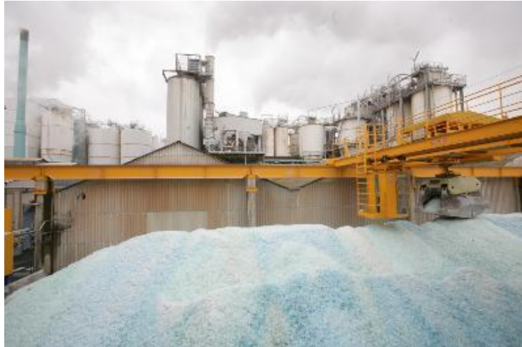
Figure 25 - Site SOLVAY de silice précipitée, Collonges-au-Mont-d'Or (69 - source Solvay).
