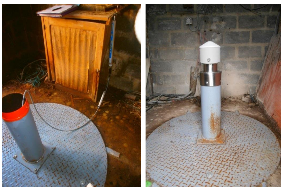
Illustration 56 : Photographies du renouvellement de matériel de l'ouvrage 01227X0022/P de Boissy-Lamberville – 27, avant (à gauche) et après (à droite) le changement de matériel.
