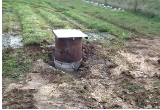
Illustration 44 : Photographie du piézomètre non finalisé 02945X0086/P1 de la Chapelle-la-Reine, 77.
