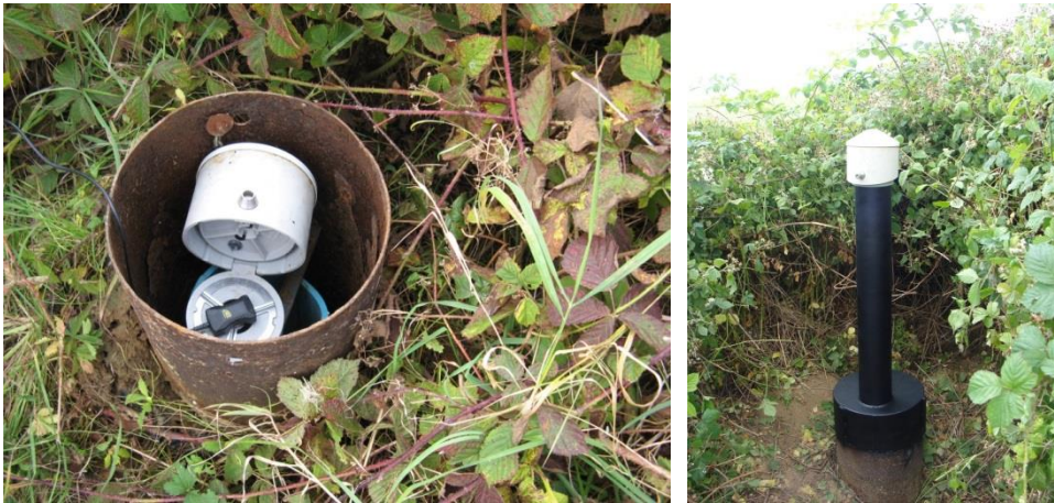
Illustration 39 : Photographies du piézomètre 01534X0049/F de Puiseux-en-France (95) avant (à gauche) et après (à droite) aménagement du site.
