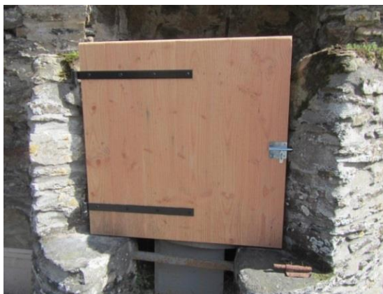
Illustration 52 : Remplacement de la porte du puits 01186X0007/P de Cerisy-la-Forêt - 50, avant (à gauche) et après (à droite) les travaux.
