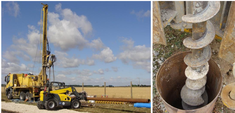
Illustration 43 : Photographie du chantier de la Chapelle-la-Reine, 77.
