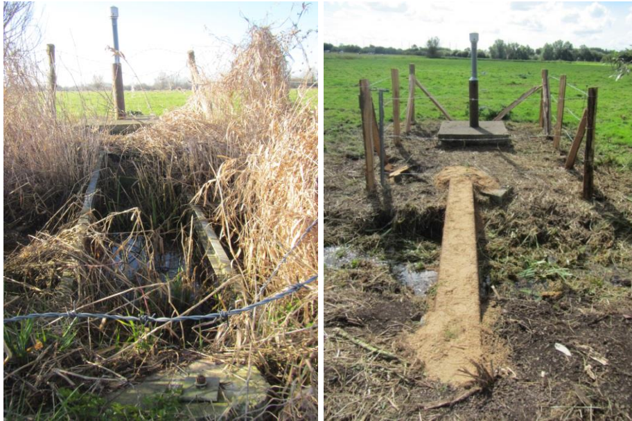
Illustration 53 : Photographies de l'entretien de l'ouvrage 00941X0034/S-2 de Fresville – 50 avant (à gauche) et après (à droite) les travaux.
