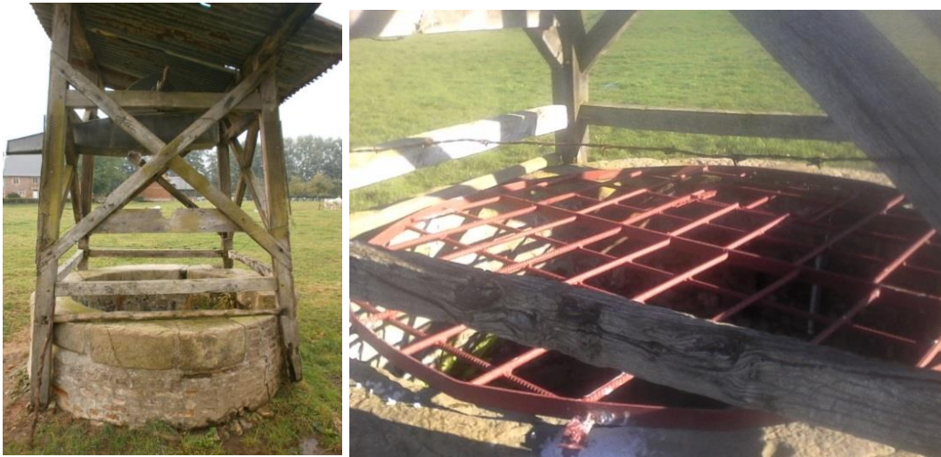
Illustration 57 : Photographies de la rénovation de l'ouvrage « 00584X0020/P » de Thil-Manneville - 76, avant (à gauche) et après (à droite) les travaux.
