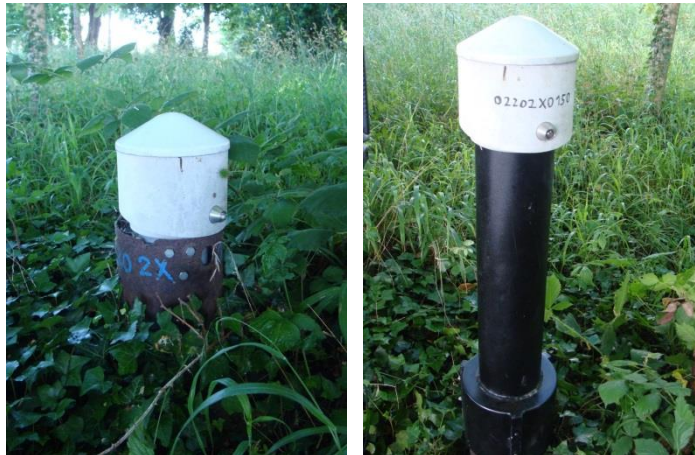
Illustration 41 : Photographies du piézomètre 02202X0150/FR de Ferolles-Atilly (78) avant (à gauche) et après (à droite) aménagement du site.
