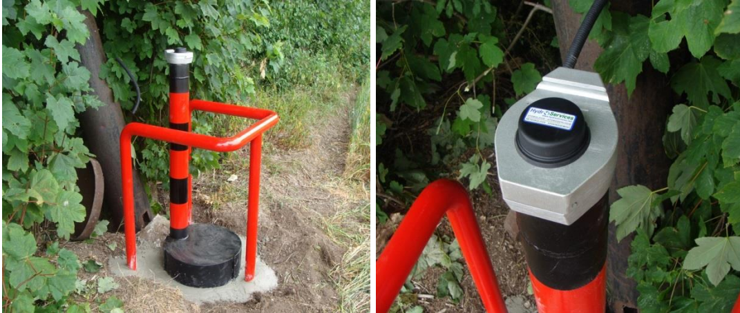
Illustration 38 : Photographies du piézomètre 02606X0112/G5 de Noyen-sur-Seine (77) avant et après aménagement du site.
