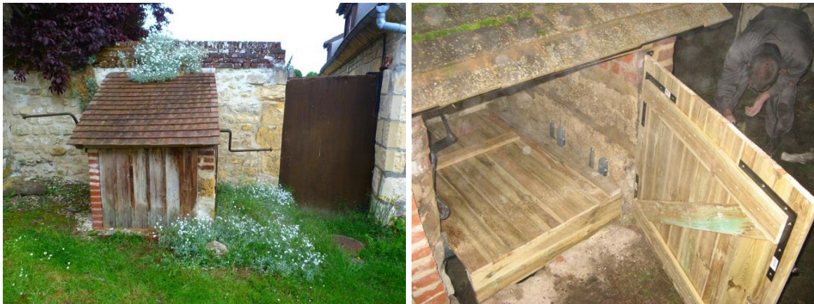
Illustration 32 : Photographies de l'aménagement du puits 01042X0033/P Hémévillers (60).
