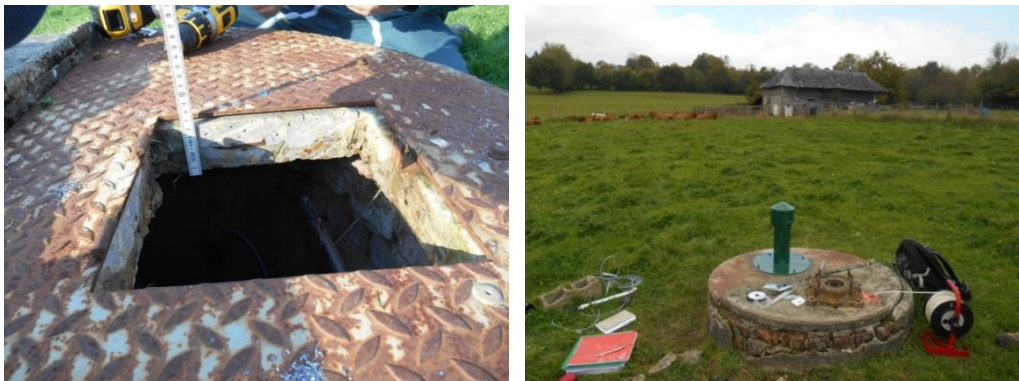
Illustration 15 : Remplacement du matériel au piézomètre « 01213X0166/S1 » (Surville) – 14.
