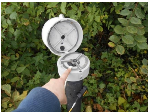
Illustration 50 : Installation du nouveau matériel au piézomètre 0956X0055/S1 situé à Asnière-en-bessin – 14.
