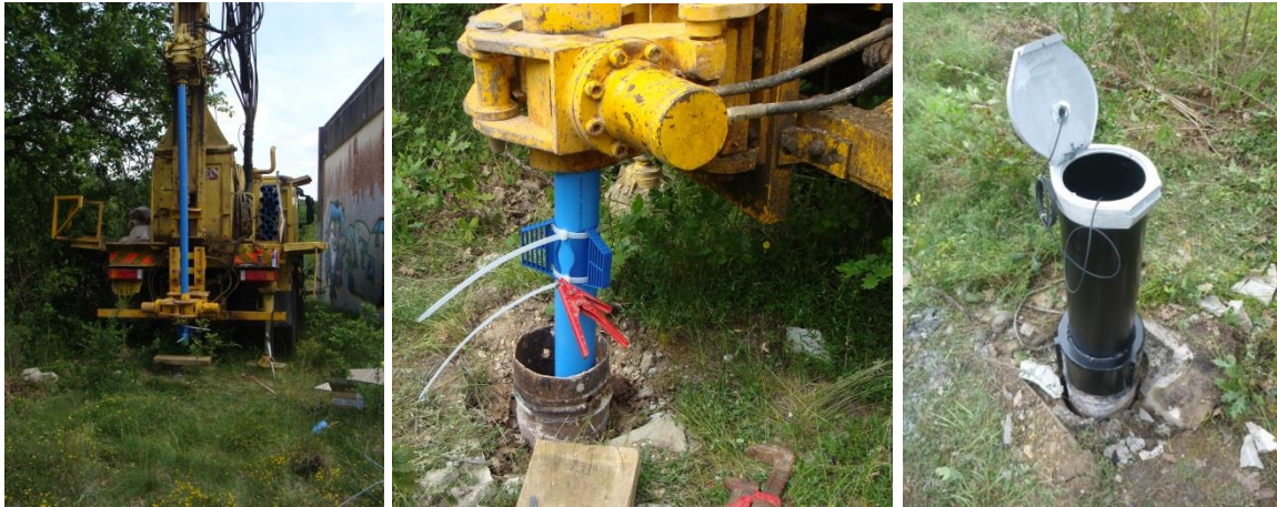
Illustration 45 : Photographies des travaux de rechemisage du piézomètre 02575X0044/F1 d'Auvers-Saint-Georges (91).
