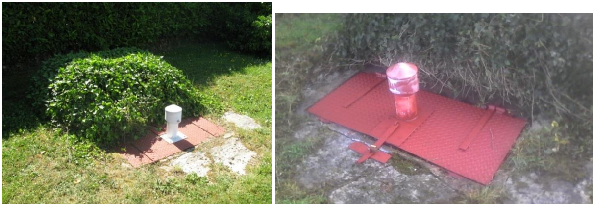
Illustration 58 : Photographies du remplacement du matériel (de la rénovation) de l'ouvrage « 01508X0100/P » de Douains – 27, avant (à gauche) et après (à droite) les travaux.
