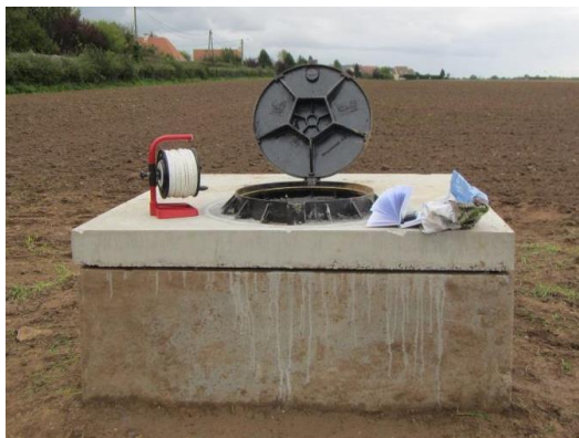
Illustration 51 : Photographies de la sécurisation du puits 01201X0108/S1 de Mathieu (14), avant (en haut) et après (en bas) les travaux.
