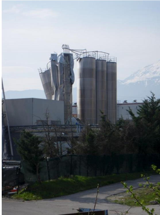
Figure 9 - Exemple de dommages aux installations industrielles : effondrement de silos métalliques, Séisme d'Aquila, 2009, AFPS.
