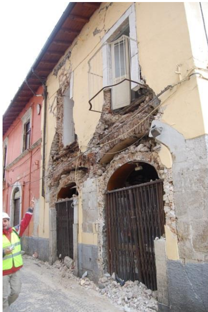
Effondrement de voûtes anciennes, L'Aquila, 2009, AFPS
