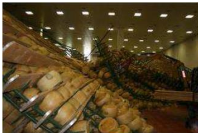
Effondrement des rayonnages d'une cave d'affinage, Séisme d'Emilie Romagne, 2012, AFPS
