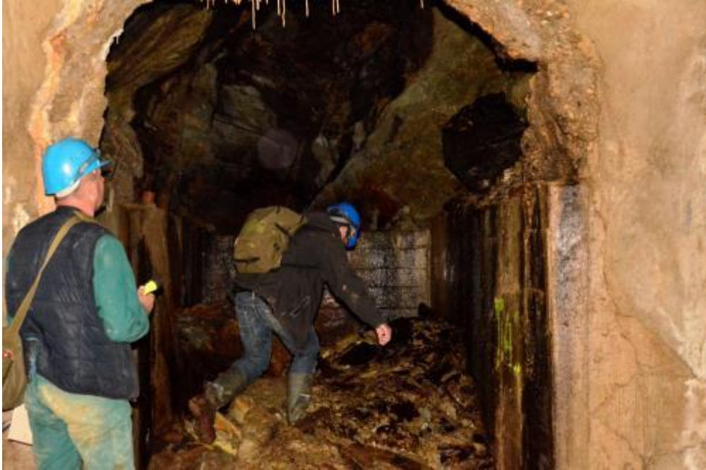
Illustration 10 : Chutes de blocs de 0.25 à 1 \text{ m}^3 du toit, signalant la mise en place d'une cloche de fontis ( H = 1 \text{ m} , \varnothing : 4 \text{ m} ; V = 5 \text{ m}^3 ), situé au premier tiers nord de la galerie 4 (Source BRGM)
