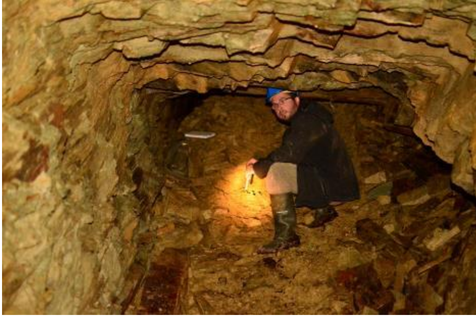
Illustration 12 : Photographie de la galerie 6 (regard vers le Sud) et du cône d'éboulis du fontis (Source BRGM)
