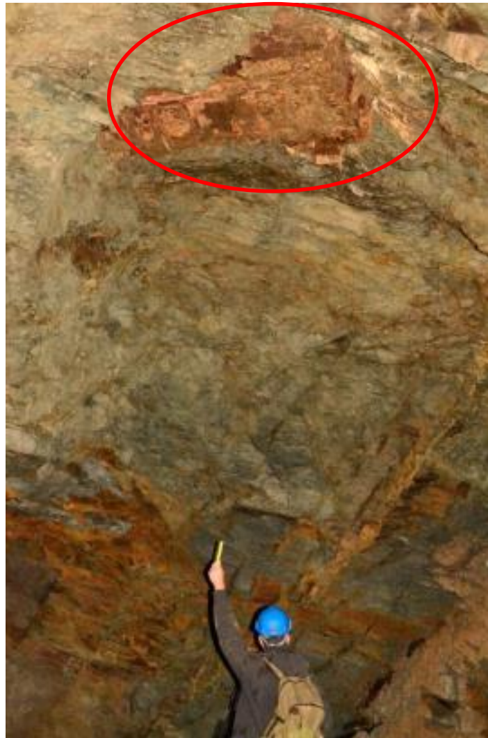
Illustration 9 : Ancien puits d'aération à l'extrémité Sud-Ouest de G4, aujourd'hui bétonné (Source BRGM)
