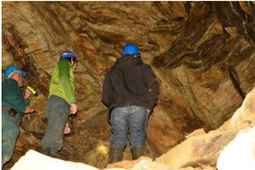
Illustration 7 : En haut, chutes de blocs de 0.5 à 1 \text{ m}^3 du toit ; et en bas, cloche de fontis située ( H = 5 \text{ m} , \varnothing : 4 \text{ m} ; V = 20 \text{ m}^3 ), à l'extrémité de la galerie G1, vers l'accès non terminé (Source BRGM)
