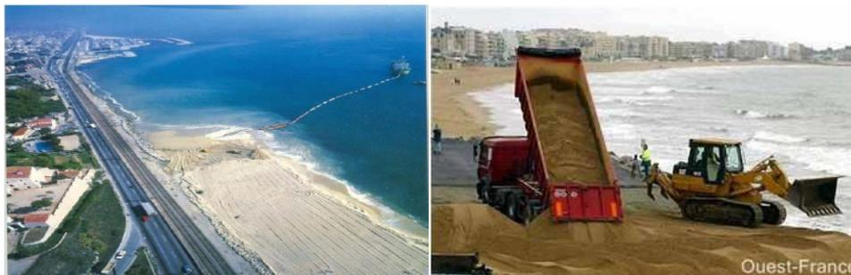
*Illustration 9 – Exemple de rechargement en sable au moyen d'une drague en mer (à gauche – Virginia beach, USA) ou par camions (à droite- La Baule, France)*
