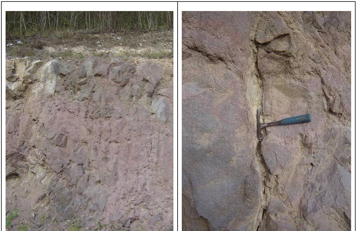
*Illustration 6 : Andésites altérées au niveau des travaux de terrassement du nouveau lotissement réalisés 350 m au Sud du 1177ZZ0161/FLF1*
