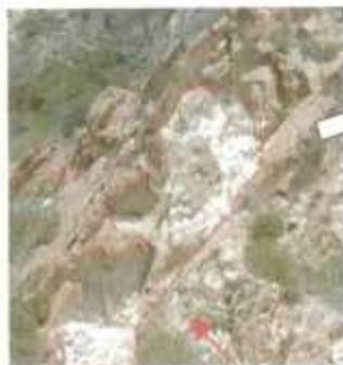
Zone de rupture récente avec dièdres rocheux apparents et roche de couleur jaunâtre
