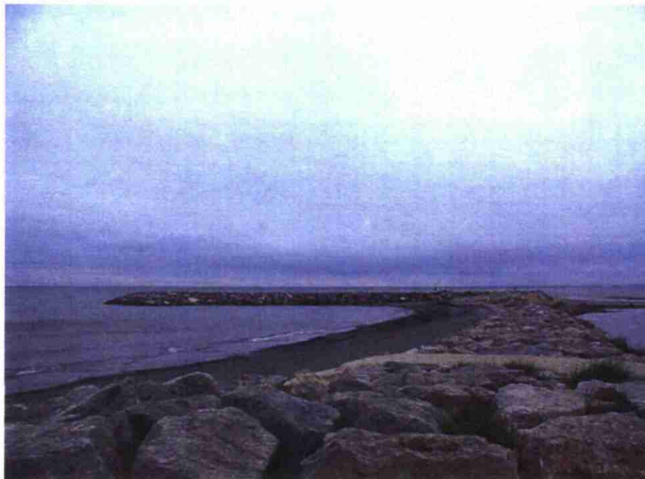
Photo 5 : ancien grand épi Est, restauré en partie avec son tenon. Plage étroite
