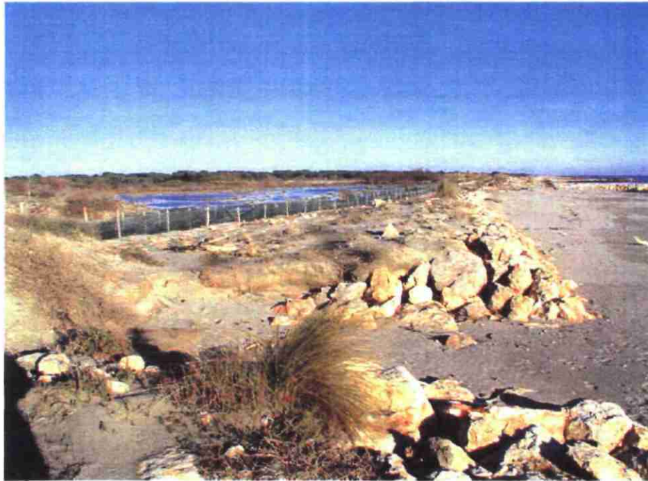
Photo 9 : ganivelles sur 200 m de longueur dans le secteur des Quatre-Maries à l'arrière d'une digue frontale
