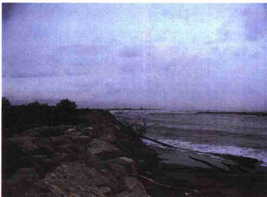
Photo 2 : digue frontale "Camping Clos du Rhône" et brise-lames (2002)
