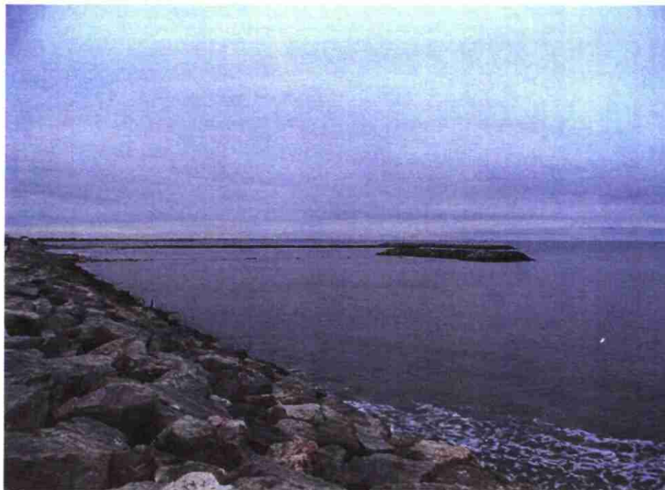
Photo 6 : digue frontale à l'est du village, au premier plan le petit brise-lames, au second plan le grand brise-lames du Grand large (épi de connexion à la digue). Absence de plage
