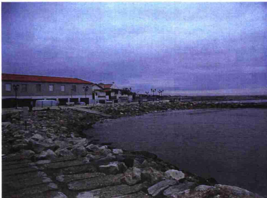
Photo 4 : ouvrages de protection sur la plage Camille (absence de plage)
