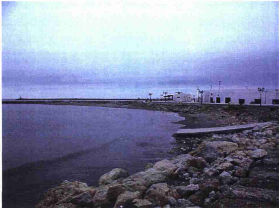
Photo 3 : plage et ouvrages de protection sur le littoral des Arènes
